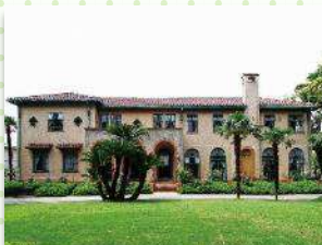
ベーリック・ホール
