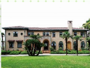
ベーリック・ホール
