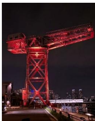
<ハンマーヘッドクレーン>
