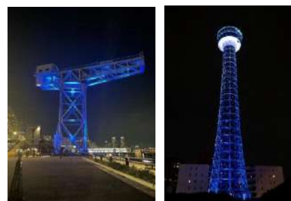
<ハンマーヘッドクレーン> <横浜マリンタワー>
